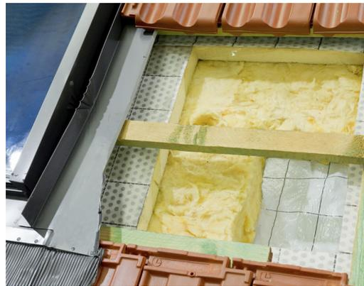
Die Aufsparrendämmung hingegen ist aufwendiger und sollte nur vom Fachmann erledigt werden. Hier wird die Dämmung von außen auf die Dachträger aufgebracht. Das bedeutet, dass bei einem Altbau das Dach erst abgedeckt und nach der Dämmung neu eingedeckt werden muss.
