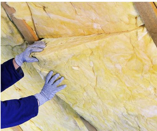
Die gängigsten Methoden der Dachdämmung sind die Zwischensparrendämmung und die Aufsparrendämmung. Als Sparren werden die Dachträger bezeichnet. Bei der Zwischensparrendämmung wird der Dämmstoff von innen zwischen die Träger angebracht. Da diese Dämmmethode relativ einfach ist, können versierte Hobbyhandwerker diese auch selbst erledigen.
